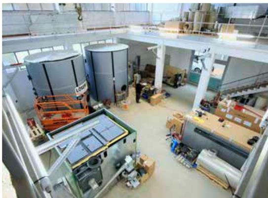
**Das Turbinenhaus im Benker Areal: Monteure installieren derzeit die neuen Heizkessel.**
