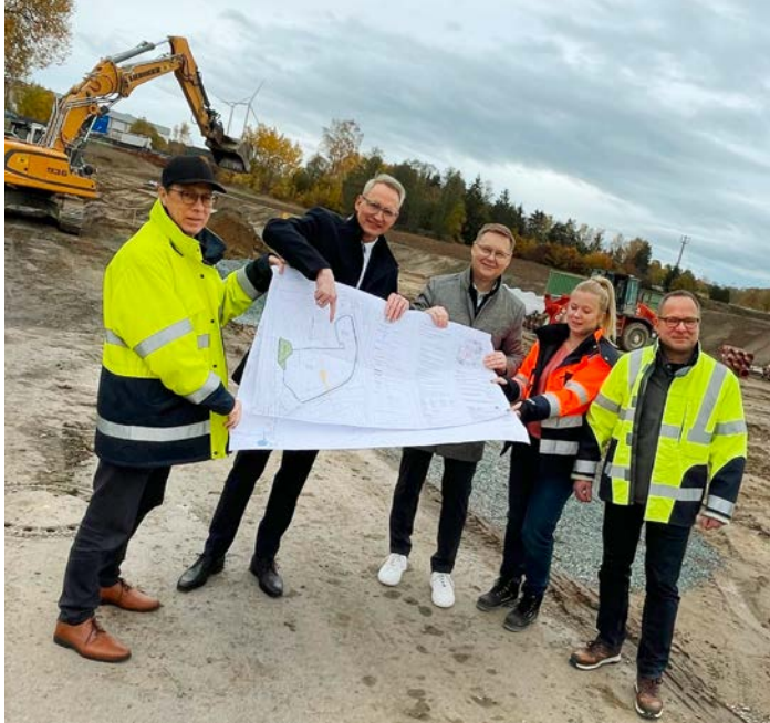
Haben die Baufortschritte zur Erschließung des östlichen Teils vom Gewerbegebiet Selb West im Blick: Klaus Burkhardt, ESM-Geschäftsführer und AWS-Werkleiter, Oberbürgermeister Ulrich Pötzsch, Wirtschaftsförderer Rainer Rädels, Stephanie Henschke, Leiterin der Kanalnetze bei der AWS, und der Technische Leiter der ESM und AWS, Andi Sprenger (v. l. n. r.).
